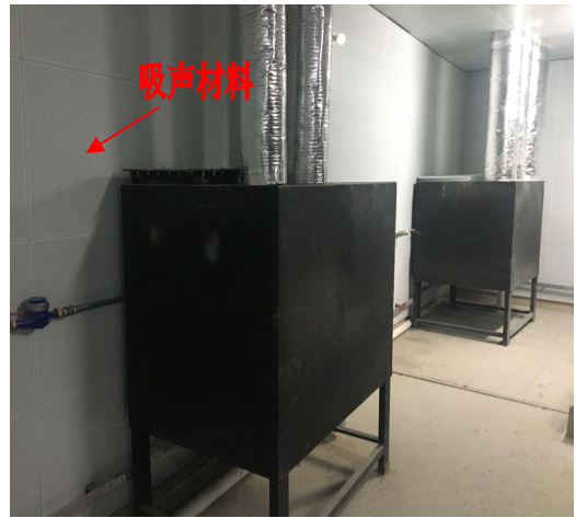
设于地下室的噪声设备采取的噪声防治措施情况
